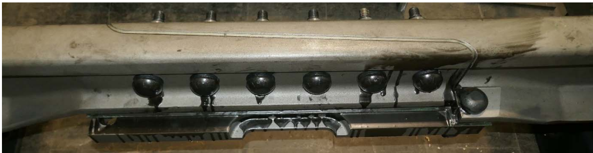
Abbildung 2: Gegenseitige Ansicht der Isolierstoß-Konstruktion „ABJ“
